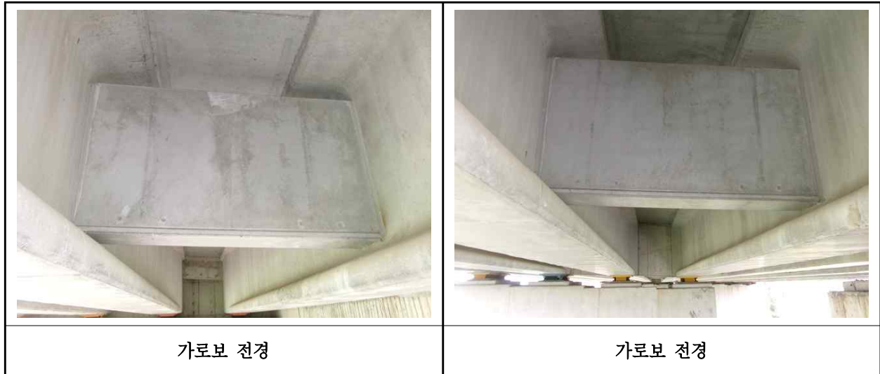
【사진 28.3.29】 가로보 전경
