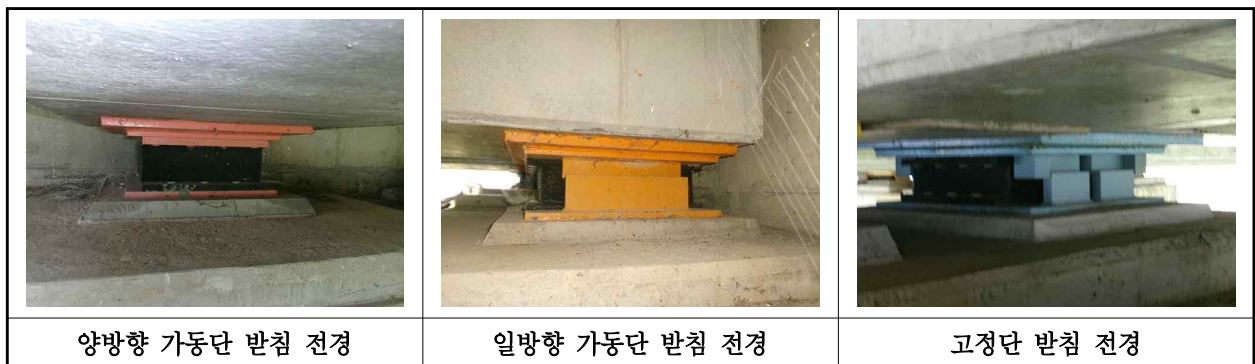
【사진 28.3.35】 교량받침 전경
