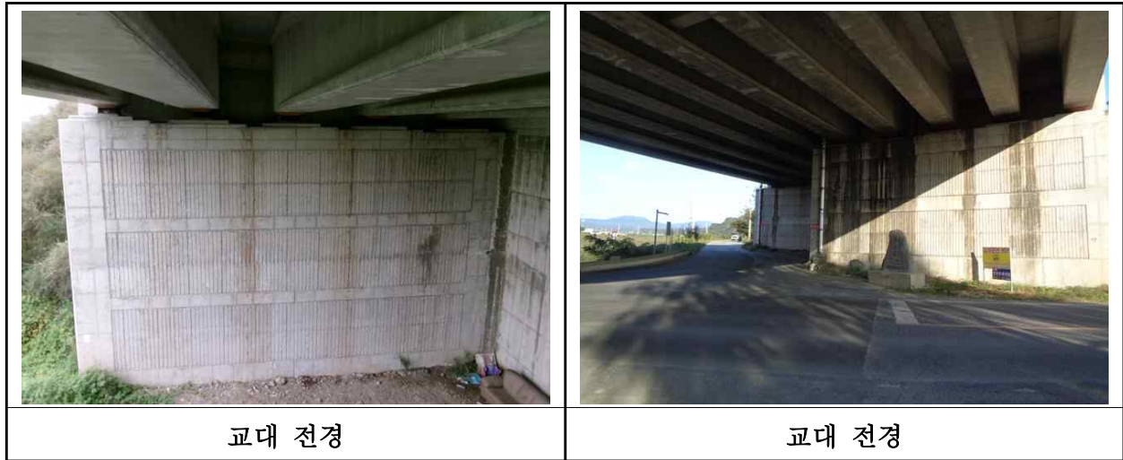
【사진 28.3.31】 교대 전경
