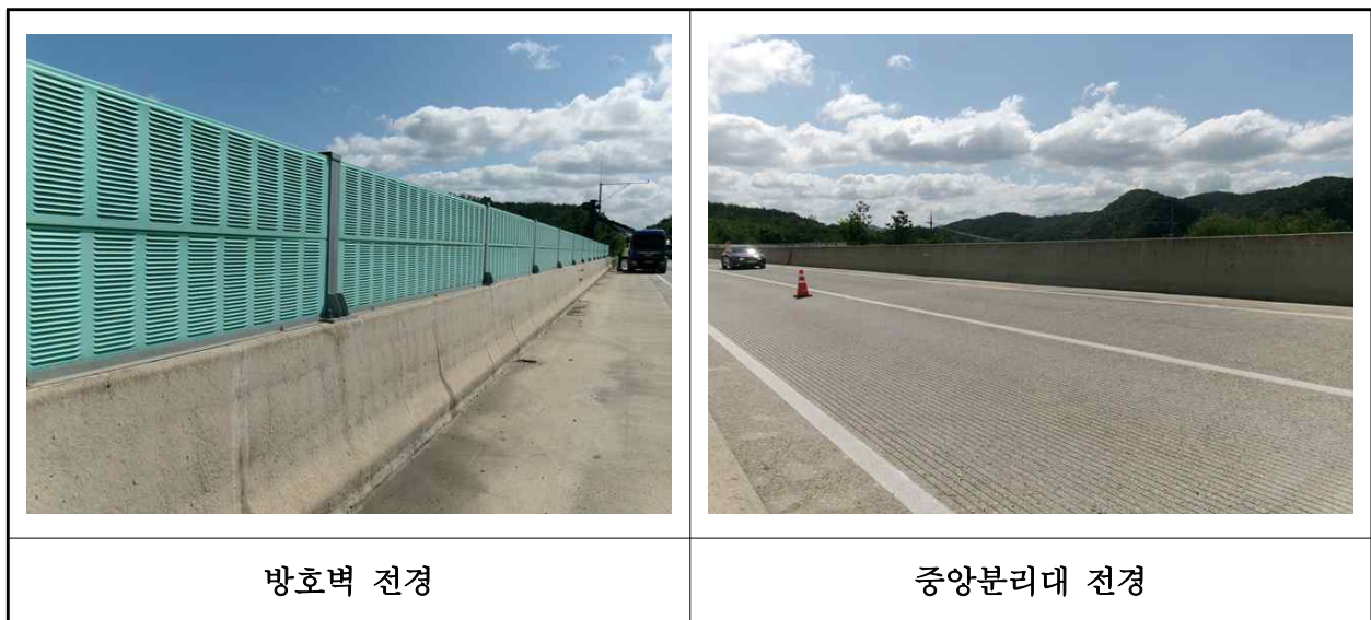
【사진 28.3.23】 방호벽 및 중앙분리대 전경
