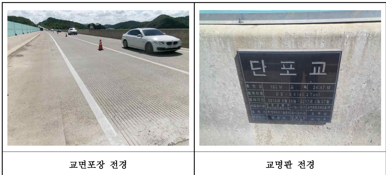
【사진 28.3.19】 교면포장 전경
