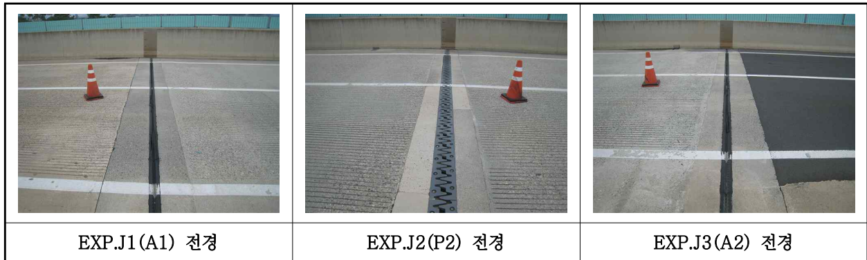
【사진 28.3.39】 신축이음장치 전경
