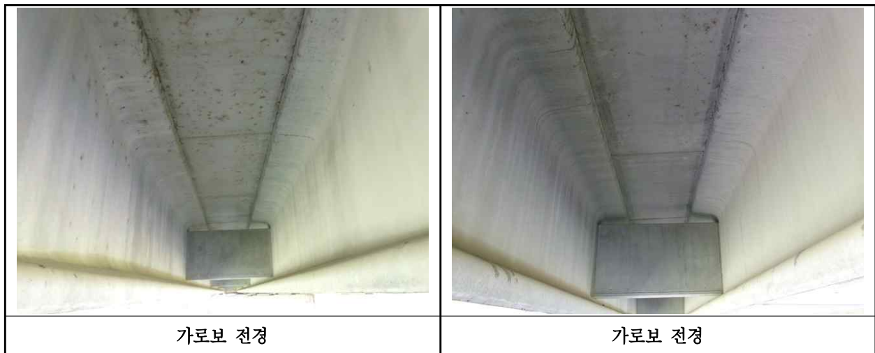
【사진 28.3.6】 가로보 전경
