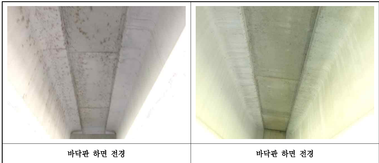
【사진 28.3.2】 바닥판하면 전경
