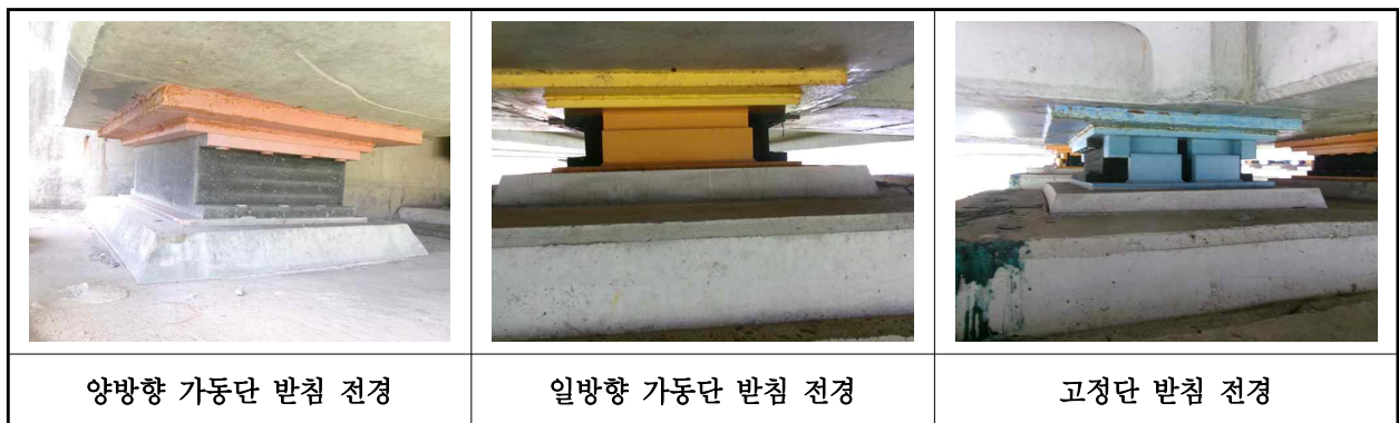
【사진 28.3.12】 교량반침 전경
