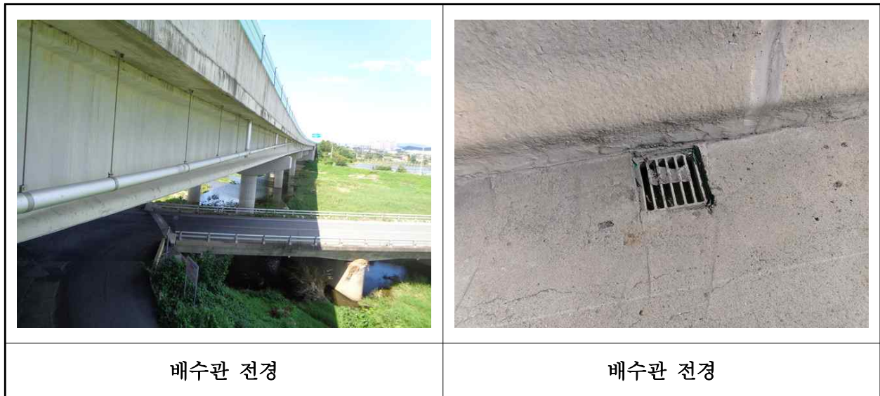
【사진 28.3.21】 배수시설 전경
