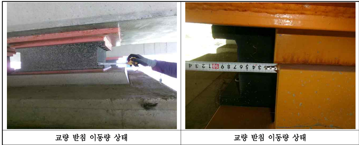
【사진 28.3.15】 교량받침 이동량 측정
