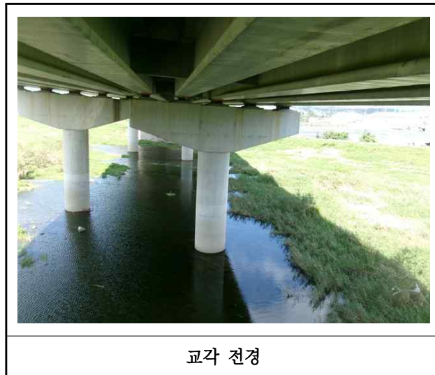
【사진 28.3.10】 교각 전경
