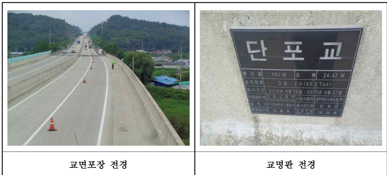
【사진 28.3.42】 교면포장 전경
