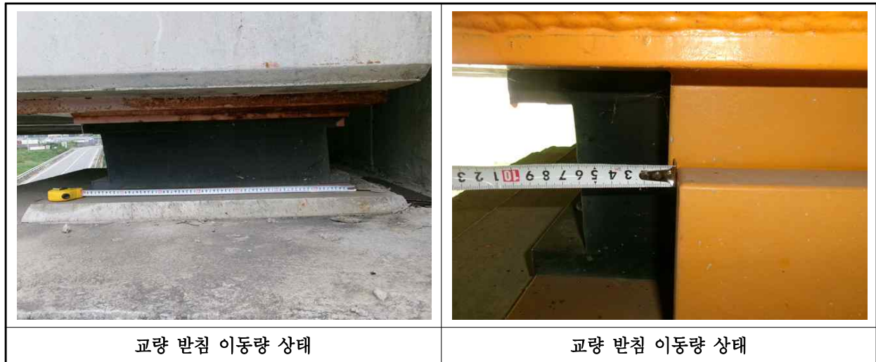
【사진 28.3.38】 교량받침 이동량 측정
