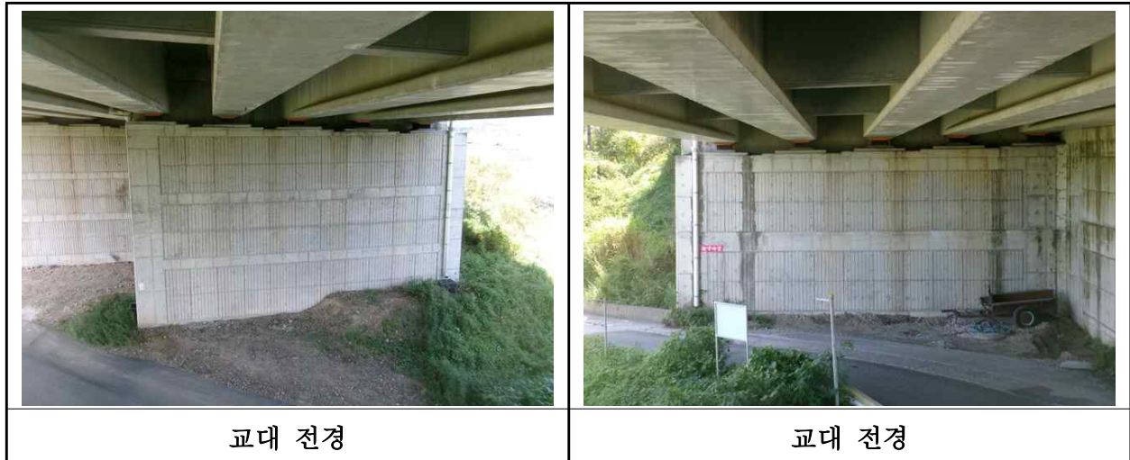
【사진 28.3.8】 교대 전경
