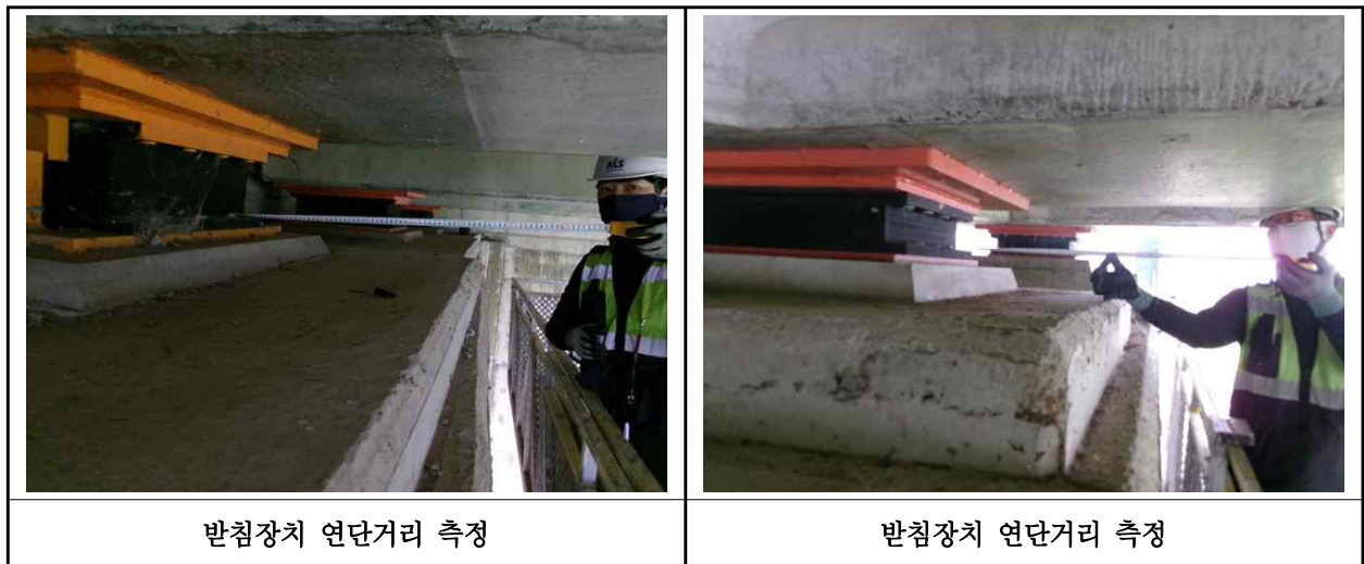
【사진 28.3.37】 교량받침장치 연단거리측정
