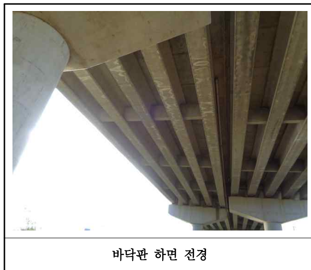
【사진 28.3.25】 바닥판하면 전경
