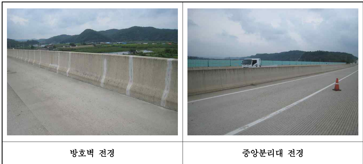
【사진 28.3.46】 방호벽 및 중앙분리대 전경
